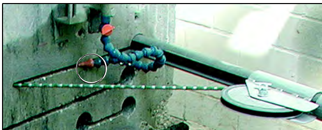
Bild 5.17 Wasserzuführung (optionale) flexible Düse
